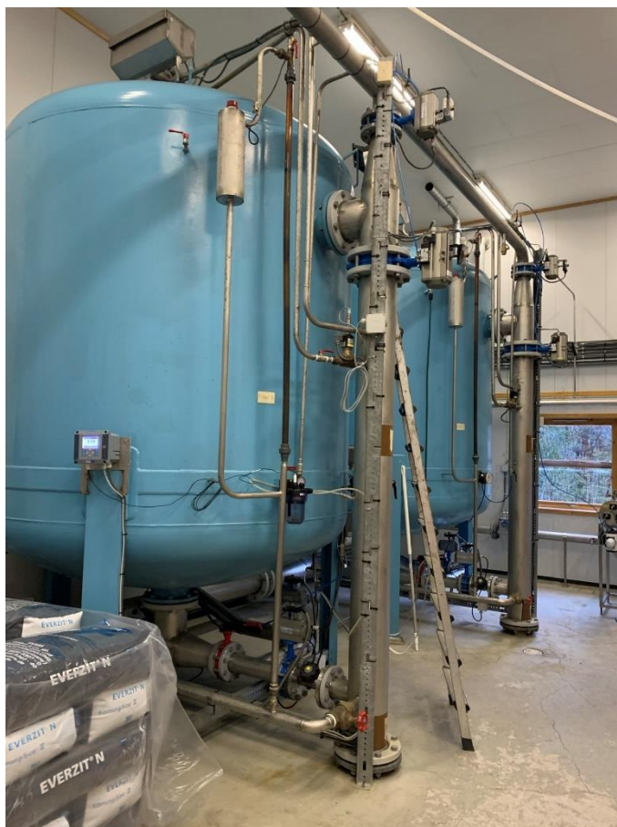
FIGUR 37: DJUPDEFILTER I KYRKJEBØ VASSVERK
