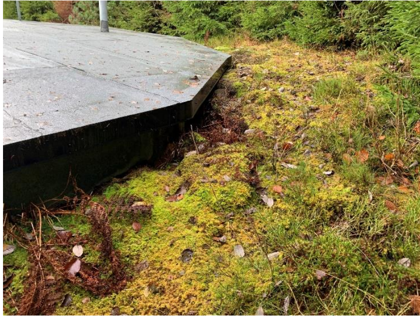
FIGUR 13: KVAMMEN HB: BAKSIDA LIGG INNTIL TERRENG.
