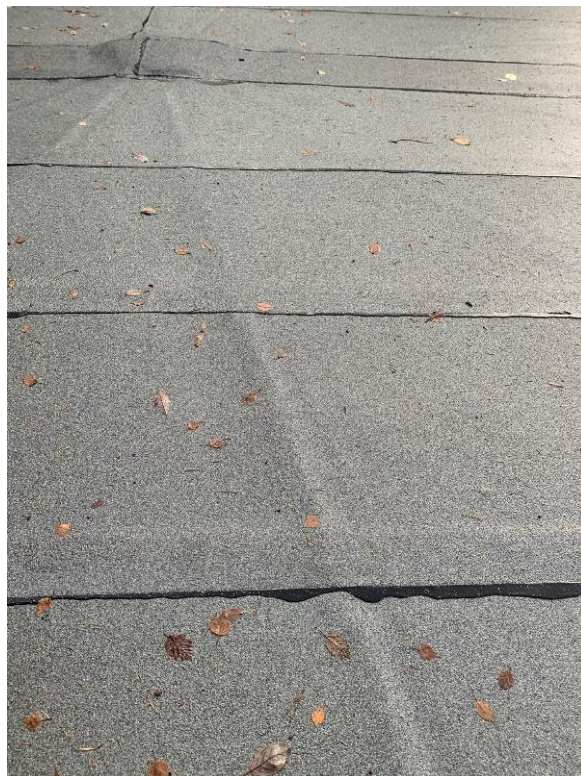
FIGUR 12: KVAMMEN HB. TETTING AV TAK MED ASFALTRULL OG SILIKON.
