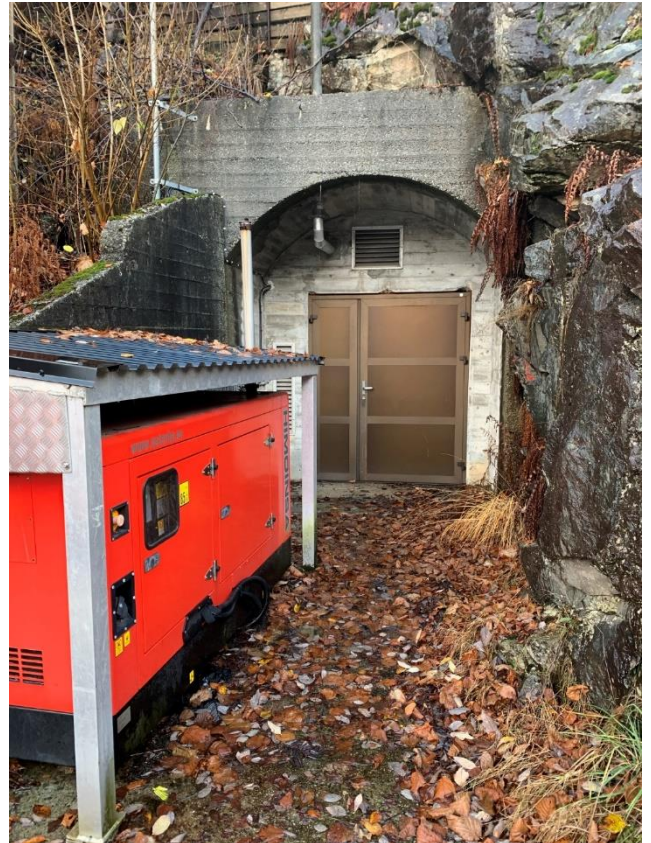
FIGUR 9: INNGANG TIL VASSBEHANDLINGSANLEGG I HØYANGER, NAUDSTRAUMSAGGREGAT I FORGRUNNEN.
