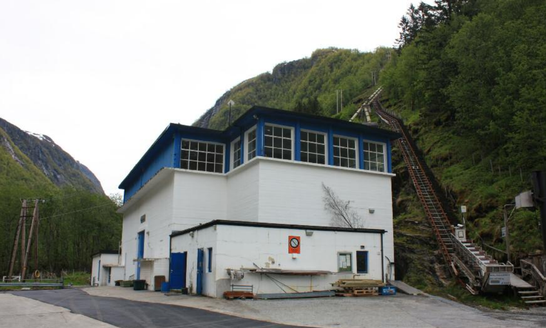
Kraftstasjon 2 med røyrgate, trallebane og trapper.
