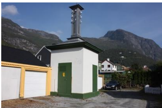
Bilete: Trafoskiosk i Høyanger sentrum
