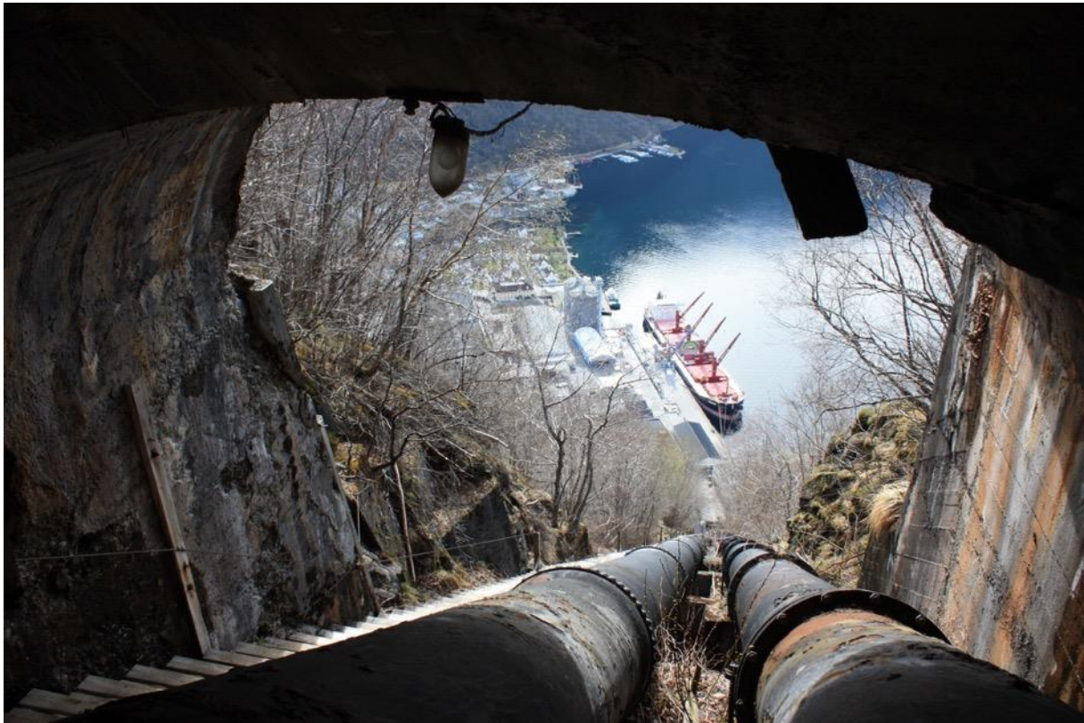
Bilete: Røyrkata ned til K1, samt trallebana
